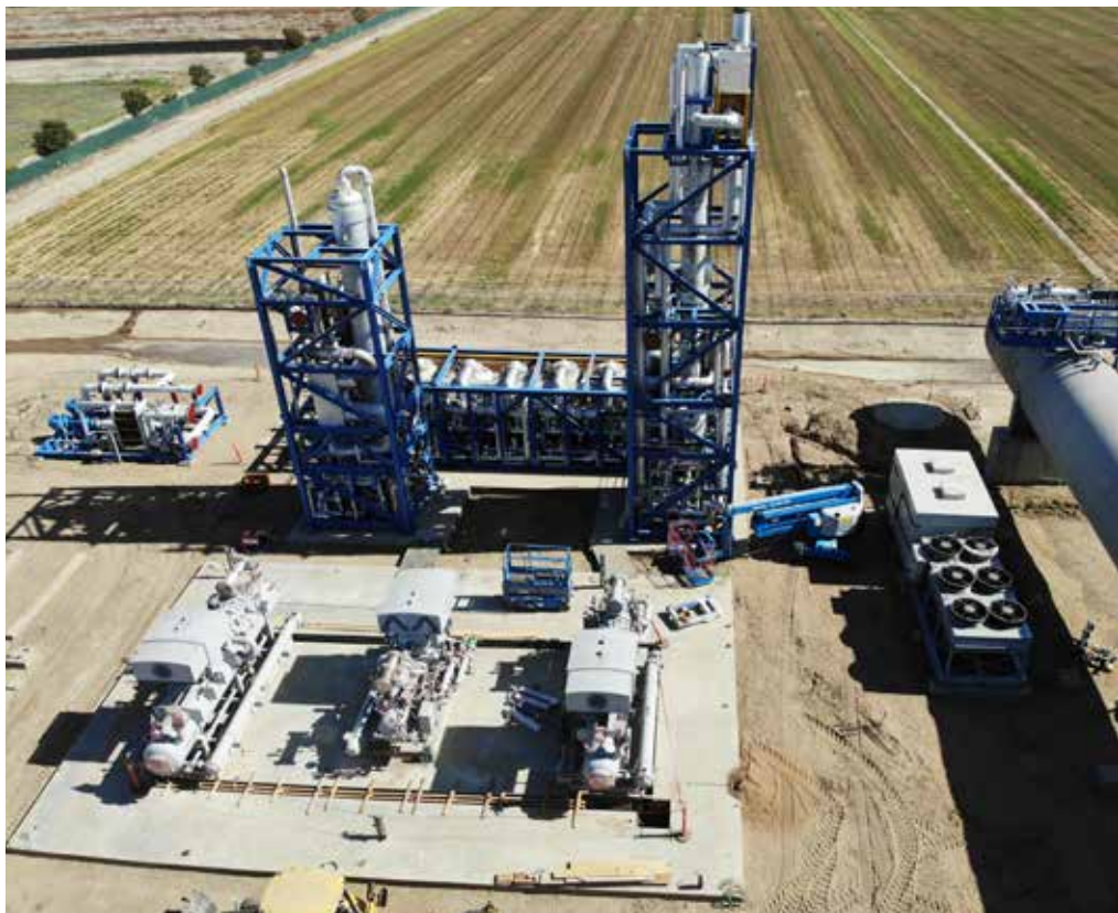
El gas bruto de la planta de CO 2 de Keyes, California, se extrae de fuentes locales y posteriormente se purifica.
