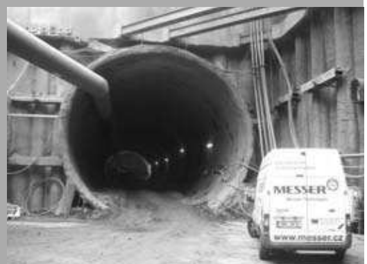
Beim Ausbau der Prager U-Bahn war Messer-Know-how gefragt.
